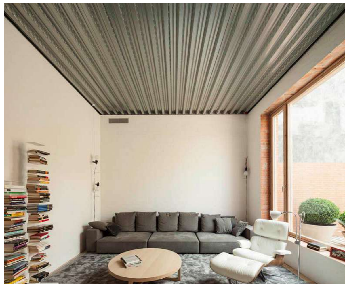
Plancher intermédiaire collaborant - sous-face métal
