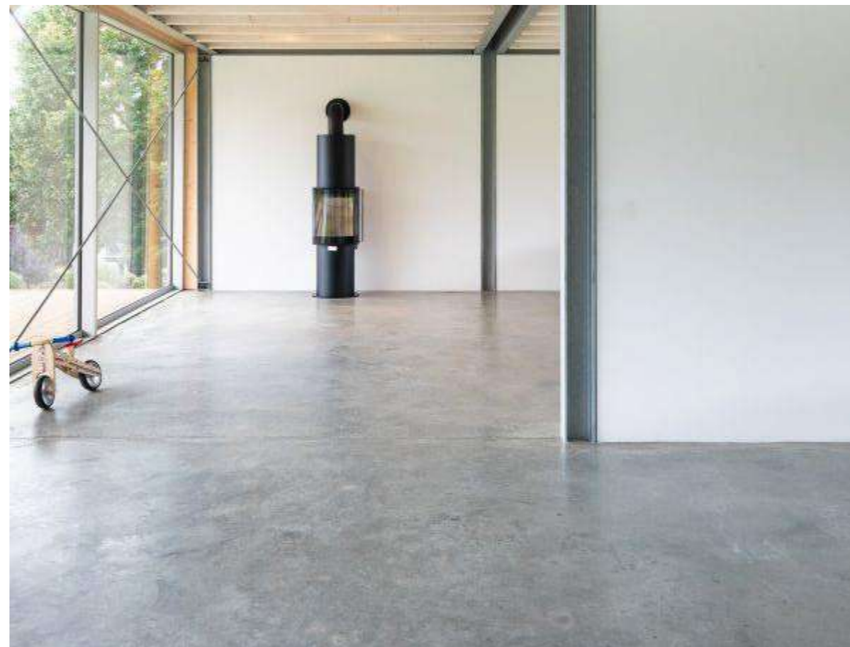
Sols béton lissé Quartzé + Doublage et cloisons plaque de plâtre peint en blanc Les sols béton peuvent faire l'objet de micro-fissuration. Une solution esthétique de sols souples pour l'étage est proposée en option + value ci-après
